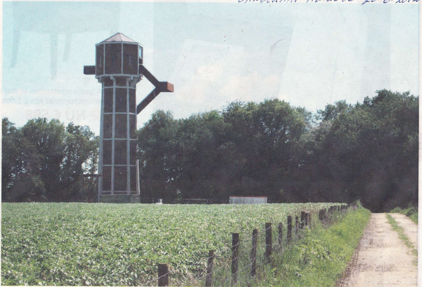
De watertoren in Rimborg is al gedeeltelijk verbouwd
