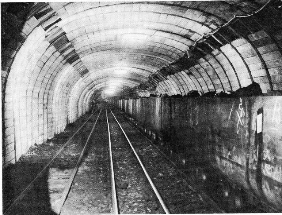
Steengang 523 met vier sporen voor de opstelling van de kolentreinen voor schacht I en schacht II. Het vierde spoor wordt hier aan het oog onttrokken door de beladen wagens. De wandbekleding bestaat uit gladde betonplaten. Deze dienen ter vermindering van de weerstand voor de ventilatie-stroom. Zoals te zien is is de wandbekleding nog niet helemaal voltooid.
